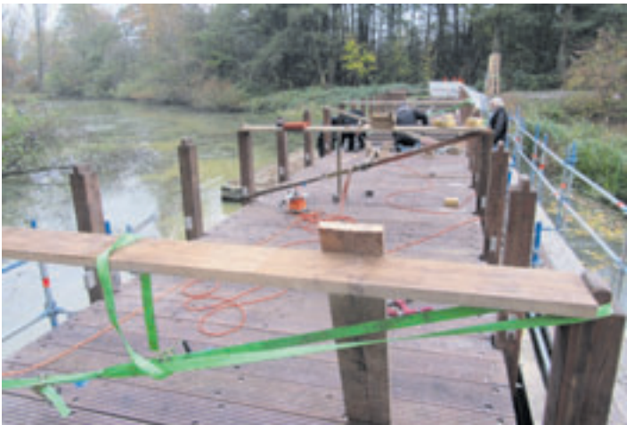
Die neue Brücke nimmt langsam Gestalt an
