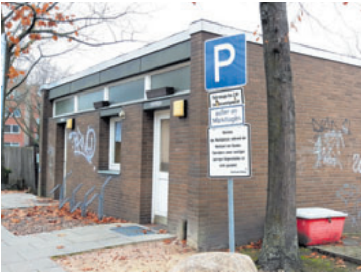
Die CDU möchte unter anderem wissen, wie weit die Planungen für die öffentliche Toilette auf dem Neugrabener Marktplatz gediehen sind Foto: W. Marsand
