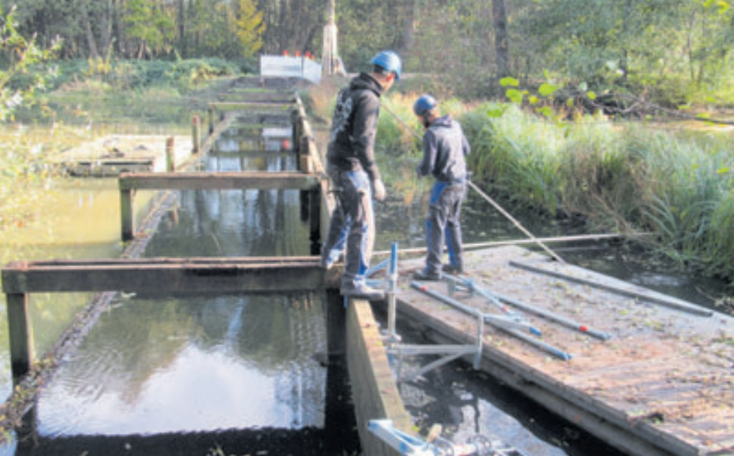
Bauarbeiter waren zunächst mit der Demontage der maroden Teile beschäftigt
