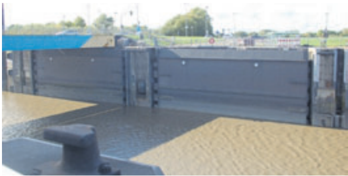
Die zunehmende Verschlickung der Este behindert die Fluttore des Esteserrwerkes in ihrer Funktion. Foto: mk
