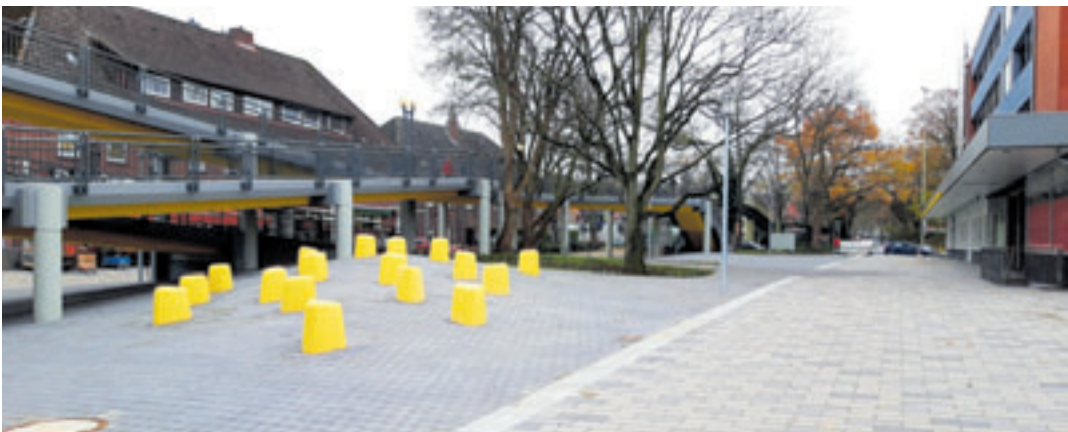
Das Umfeld der Fußgängerbrücke im Bereich der Neugrabener Bahnhofstraße wurde grundlegend saniert
