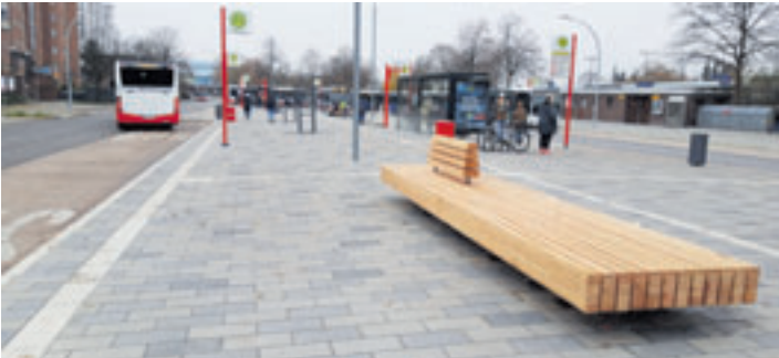
Die Mittelinsel des S-Bahnhofes Neugraben wartet unter anderem mit neuer Pflasterung und einladenden Sitzmöglichkeiten auf
