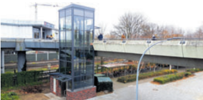
Auch der neue Aufzug hat seinen Betrieb aufgenommen
