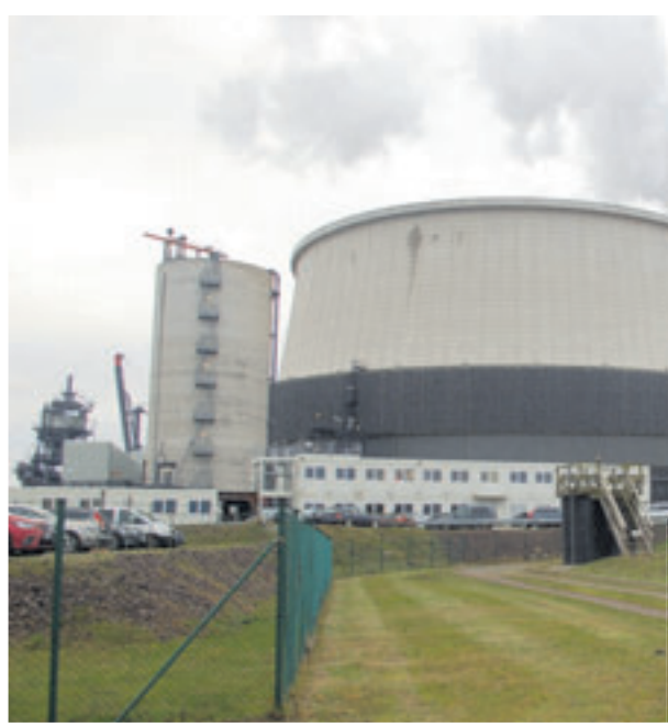
Das erst 2015 in Betrieb gegangene Kohlekraftwerk Moorburg soll bereits 2021 wieder abgeschaltet werden Fotos: mk
