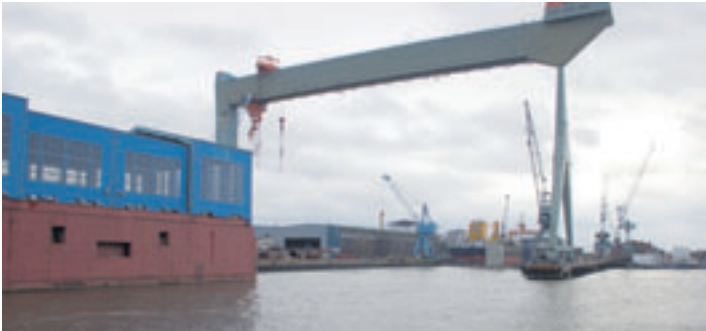
Die Sietas-Werft wurde 1635 von Carsten Sietasch gegründet Foto: mk
