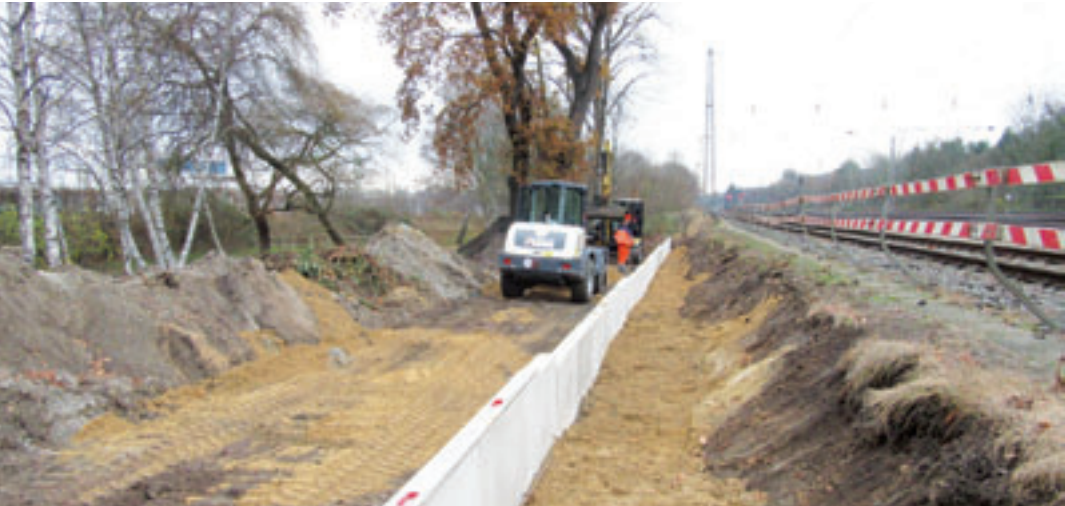
Ein weiteres Stück der Veloroute 10 wird gerade fertiggestellt
