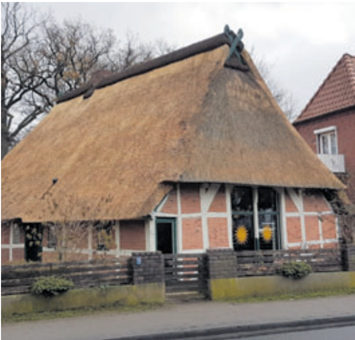
Das Reetdach der alten Bauernkate wurde fachgerecht instandgesetzt
