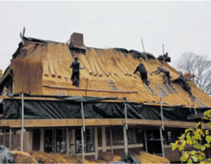
Das Reetdecken war ein weiterer Schritt zur originalen Instandsetzung der Kate aus dem 17. Jahrhundert Fotos: Theilmann
