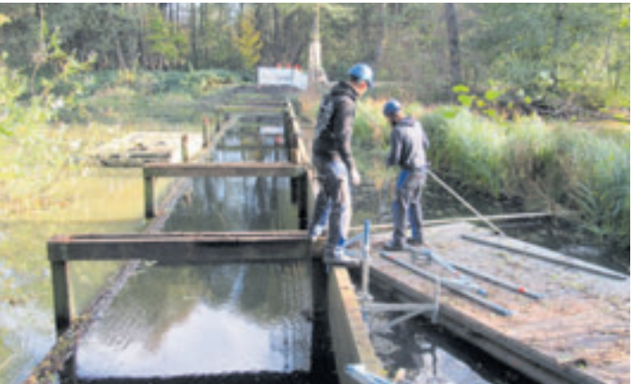
Anfang November war die Holzbrücke beinahe vollständig demontiert worden
