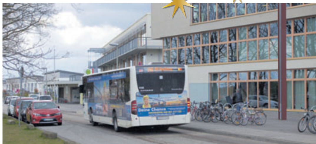
Das BGZ Süderelbe wurde 2012 offiziell eingeweiht
