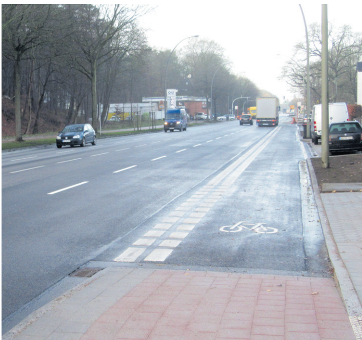
In diesem Abschnitt der Veloroute 10 von der Hamburger City nach Neugraben wurden weitgehend die Standardbreiten für Radschnellwege von 2 m umgesetzt Foto: W. Marsand
