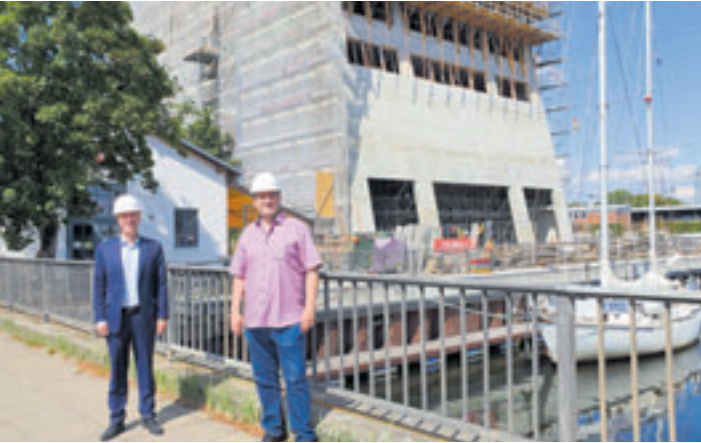
Prof. Dr. Carlos Jahn (li.) und Metin Hakverdi vor dem im Bau befindlichen Fraunhofer-Center
