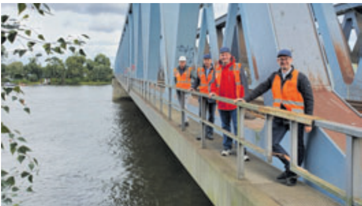
Machten sich ein Bild vor Ort (v.r.): Sven Kollath, Projektleiter Sanierung, Metin Hakverdi (MdB), Axel Boss, Leiter Produktionsdurchführung Hamburg, DB Netz AG und Marc Szelinski, Projektleiter Neubau Foto: SPD
