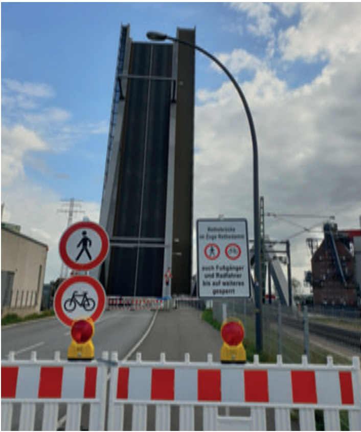
Mindestens noch bis Mitte November bleibt die Rethelklappbrücke für Autofahrer, Fußgänger und Radfahrer gesperrt Foto: au
