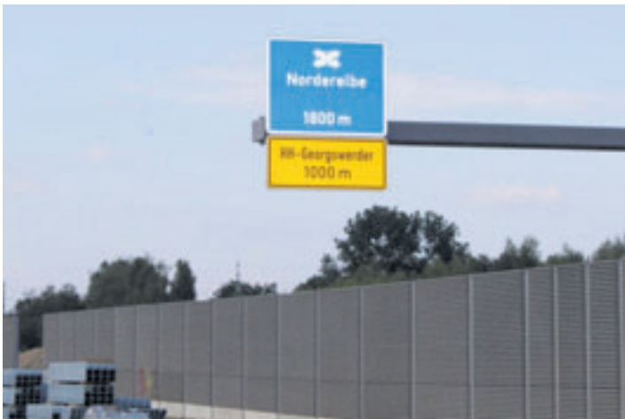
Während der Bauphase bleibt die Anschlussstelle (AS) HH-Georgswerder über provisorische Beschleunigungs- und Verzögerungstreifen beziehungsweise Verflechtungstreifen für die Nutzer geöffnet Foto: au
