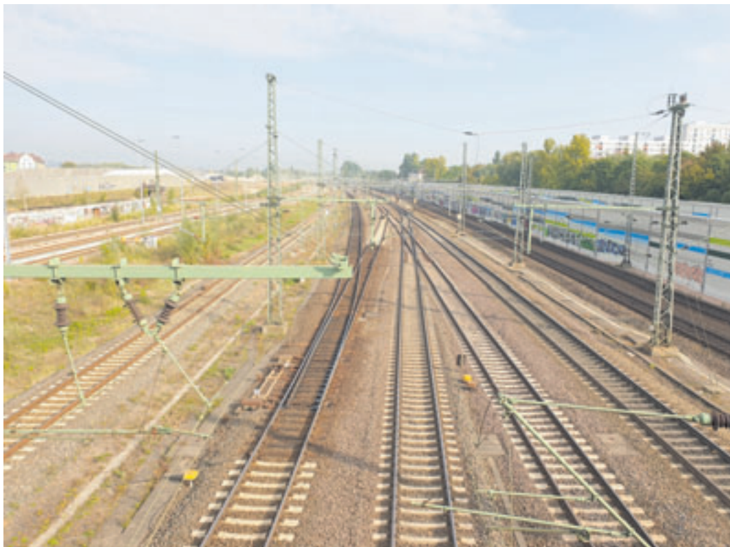
In Höhe der Thielenstraße plant die Deutsche Bahn ein Kreuzungsbauwerk in Form einer Unterführung. Dort soll dann zukünftig der Güterverkehr unter den Personengleisen hindurch geleitet werden Foto: au
