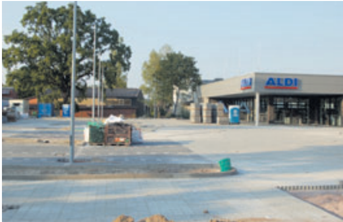
Die Pflasterungsarbeiten sind so gut wie abgeschlossen
