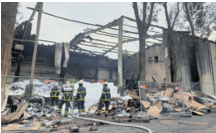
Auch am Mittwochvormittag, rund 90 Stunden nach Ausbruch des Feuers, pumpten die Einsatzkräfte der Feuerwehr Hamburg noch Löschschaum in den Keller der Lagerhalle Foto: au
