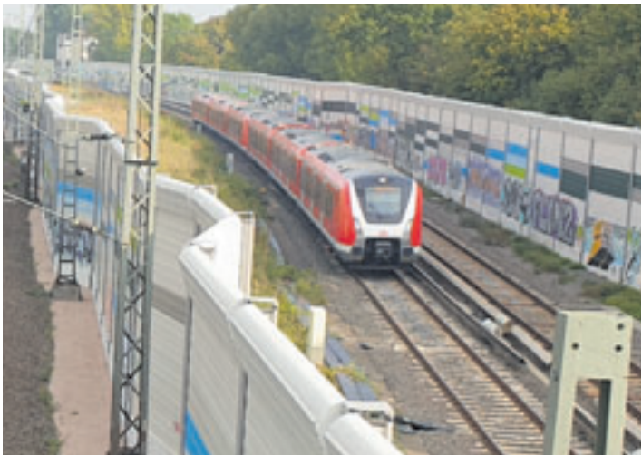
S-Bahn-Reisende der S3/S31 müssen sich auf Einschränkungen einstellen. Grund dafür sind Schienenerneuerungen zwischen Wilhelmsburg und Hammerbrook. Foto: au
