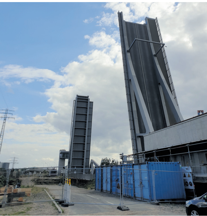
Die Reparatur der Retheklappbrücke verzögert sich weiter
