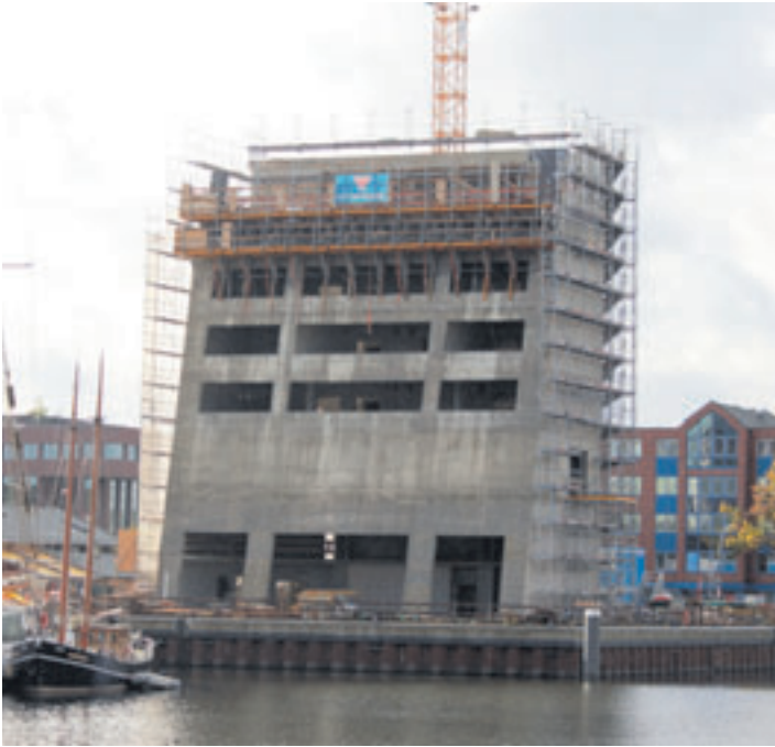
Im Binnenhafen entsteht das neue Domizil des Fraunhofer CML: Ziel ist die Weiterentwicklung des CML in Richtung eines eigenständigen Fraunhofer-Instituts zugunsten des maritimen Wirtschafts- und Wissenschaftsstandortes Hamburg. Foto: pm
