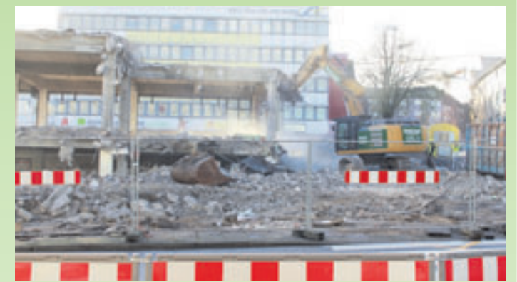
Der Abrissbagger leistet ganze Arbeit
