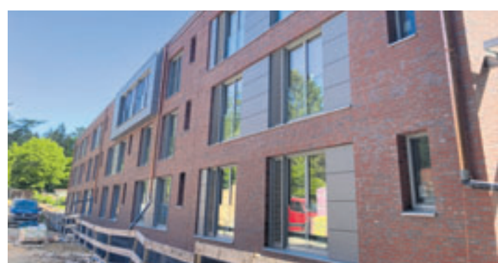
Der Innenausbau und damit auch die hochmoderne technische Gebäudeausrüstung sind jedoch noch in vollem Gange
