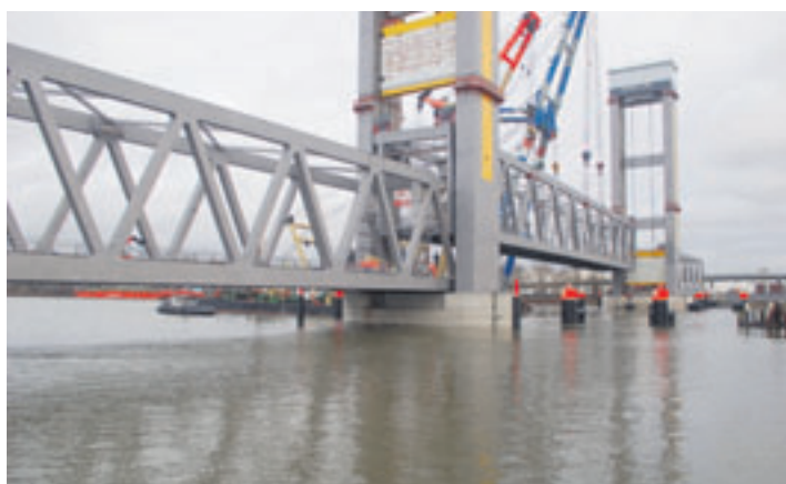
Im Dezember 2019 wurde die neue Bahnbrücke Kattwyk installiert
