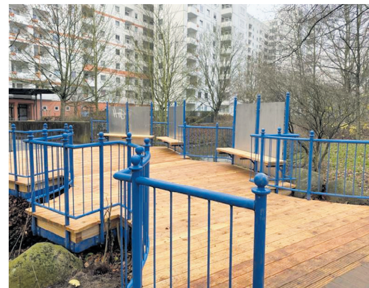
Wieder begehbar: Die Fußgängerbrücke am Erlerring wurde nach mehr als sechs Jahren endlich saniert Foto: Bezirksamt Hamburg-Mitte
