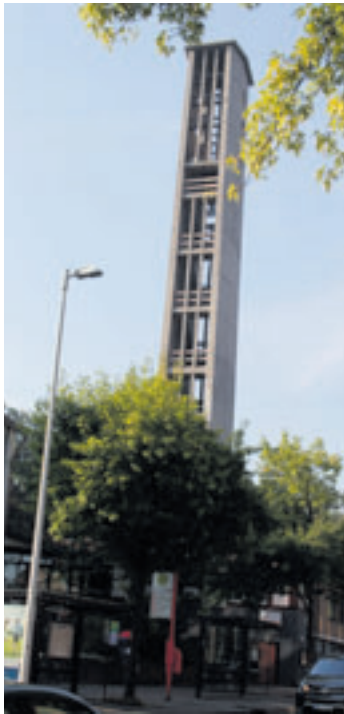
Das Schicksal des Kirchturms von St. Jonannis ist noch nicht besiegelt Foto: pm
