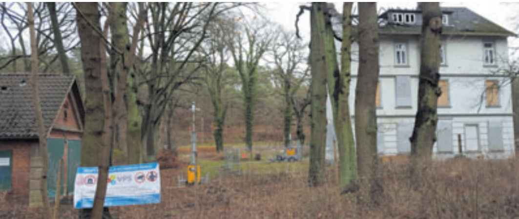
Die Sprinkenhof AG hat den Alten Jägerhof massiv gegen unbefugte Besucher gesichert. Foto: H.H. Fischer
