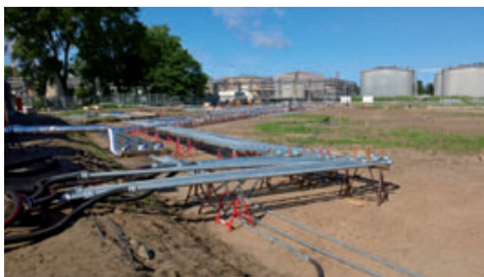
Die aufwendige Sanierung der Fläche ist abgeschlossen
