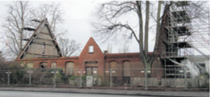
Die Einrüstung der Brandruine wurde vor Tagen größtenteils demonstert Foto: W. Marsand
