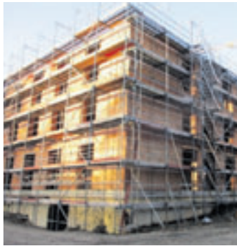
Der Rohbau des Ersatz-Gebäudes am Ev. Krankenhaus Ginsterhof Foto: G. Vauk
