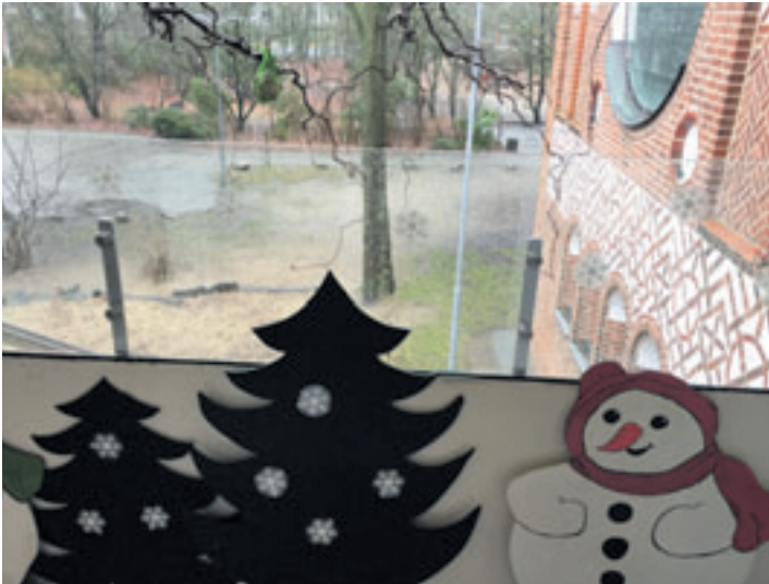
Die Brüstung des Balkons erhielt eine zusätzliche Plexiglasscheibe als Absicherung
