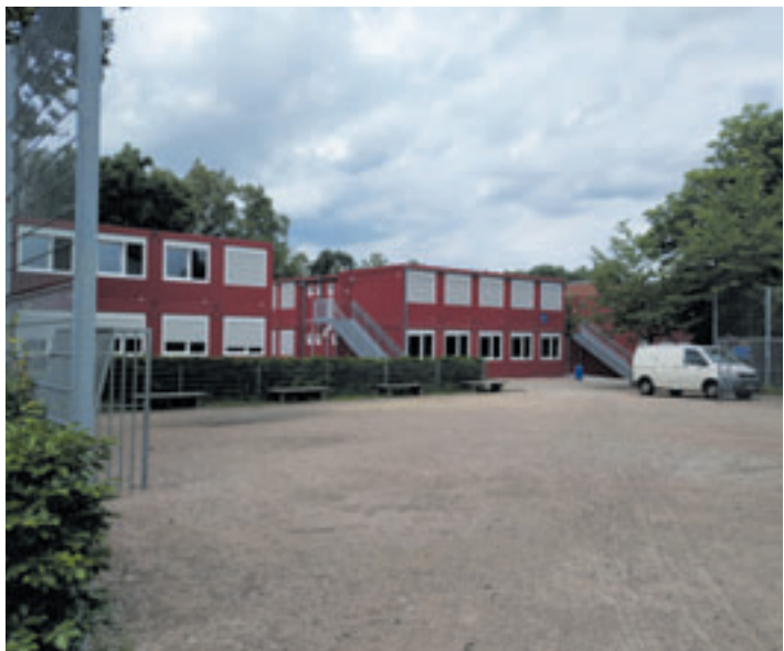
Auf dem Gelände der Schule Fischbek-Falkenberg stehen die mobilen Klassenräume bereits und befinden sich im Innenausbau Foto: H. Reh
