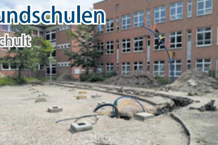
Auch am Ohrns Weg sind die Anschlüsse und Fundamentarbeiten erledigt. Auch hier werden täglich die mobilen Räume erwartet. Foto: H. Reh
