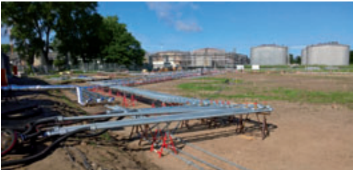
Die aufwendige Sanierung der Fläche ist abgeschlossen Foto: Umtee Prof. Biener | Sasse | Konertz
