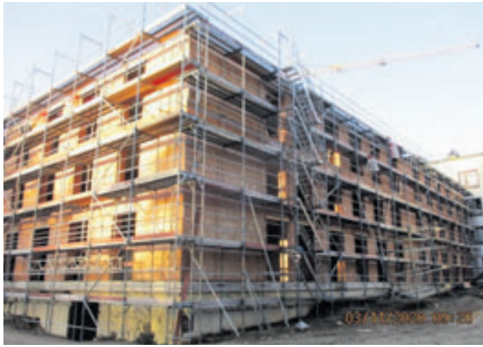
Der Rohbau des Ersatz-Gebäudes am Ev. Krankenhaus Ginsterhof
