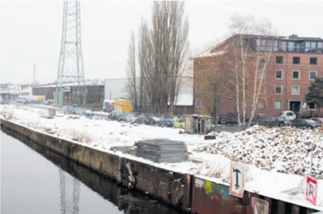
Nach Beendigung der Sanierung der Kaimauer am Treidelweg könnte hier der neue und von den Harburgern herbeigesehnte Beachclub entstehen Foto: pm
