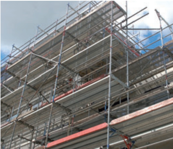
Gerüstbauer/innen montieren Gerüste aus Systembauteilen oder errichten Spezialgerüste, beispielsweise bewegliche Arbeitsplattformen an Bauwerken Foto: mk
