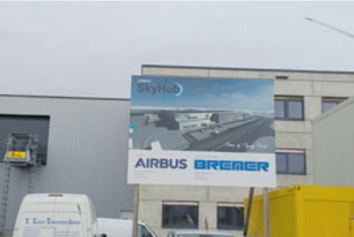
Der Rohbau für den SkyHub steht bereits Foto: pm
