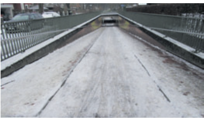
Die Benutzung der Unterführung Francoper Straße war trotz des Einsatzes „von abstumpfenden Streumitteln“ schwer möglich Fotos: W. Marsand
