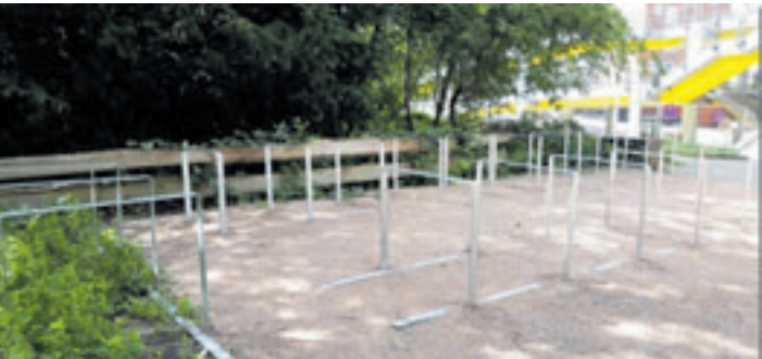
Der Neugrabener S-Bahnhof soll im Zuge seiner Modernisierung bis Ende 2021 über bis zu 906 Fahrradstellplätze verfügen Fotos: W. Marsand
