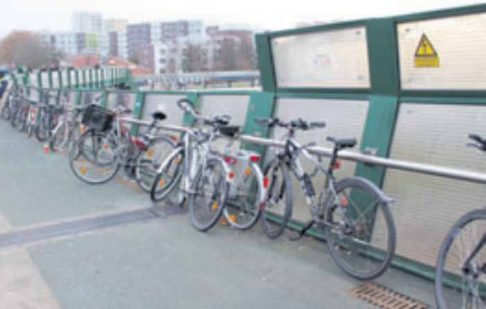
Fahrrad-Pendler schließen ihre Zweiräder immer wieder am Handlauf der Muharrem-Acar-Brücke ab und blockieren so den Handlauf für ältere, sehbehinderte und mobilitätseingeschränkte Menschen Foto: au
