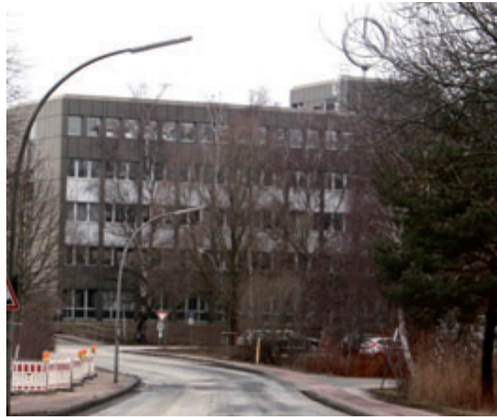
Das Verwaltungsgebäude des Mercedes-Werkes in Bostelbek Foto: pm
